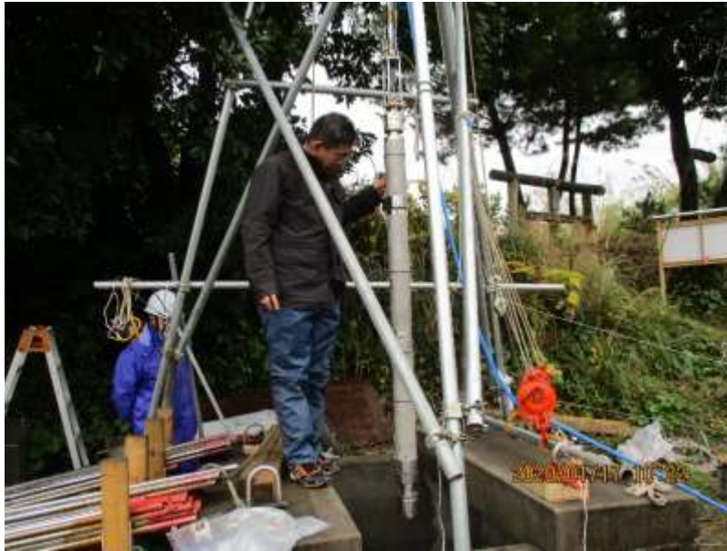
図 72 固定具を使った埋設型地震計・傾斜計の再設置作業状況。
